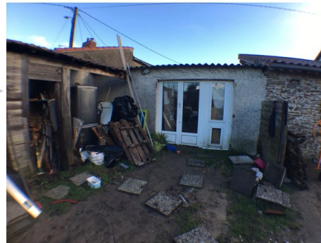
Le jardin (en chantier) vu du garage
